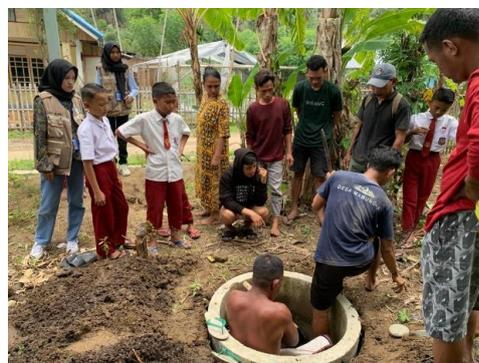
Gambar 3. Memasukkan Buis ke dalam Lubang
