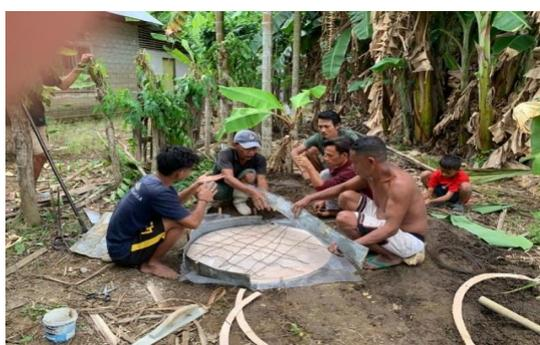
Gambar 6. Pembuatan Tutup Teba Modern
