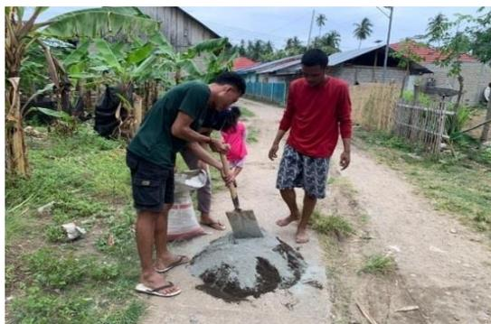
Gambar 5. Proses Pencampuran Semen untuk Pembuatan Penutup
