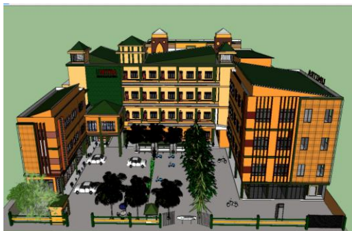
Gambar 4.1 Tampilan Gedung Tampak Depan
